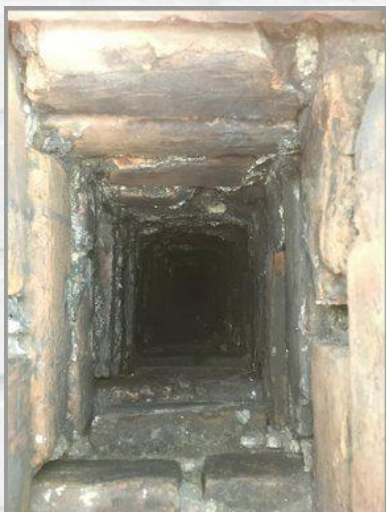
ДЫМОХОД ДО ОБМУРОВКИ
