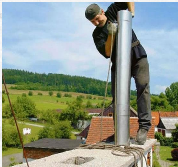
Гильзование каналов металлической трубой
